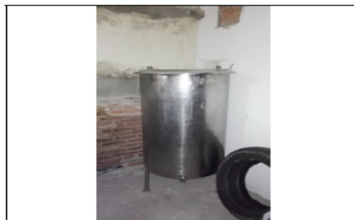
FOTO 2. CALDERA EN DESMANTELAMIENTO
